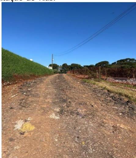
Figura 48: Pavimentação de vias.
