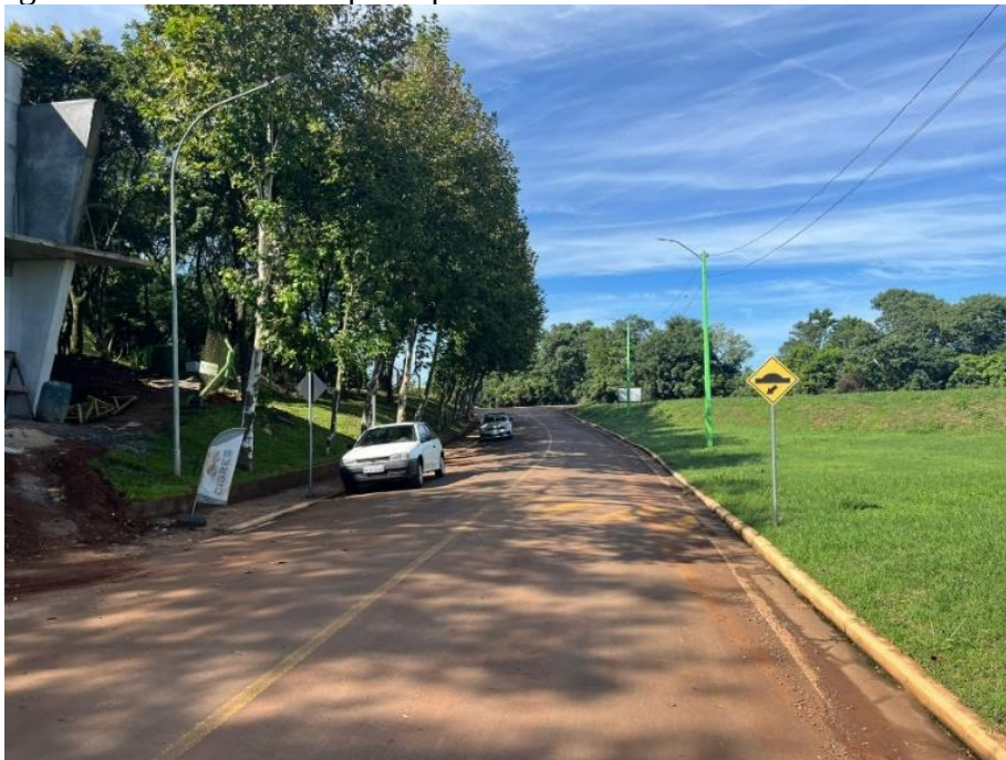
Figura 17: Via de acesso principal.
