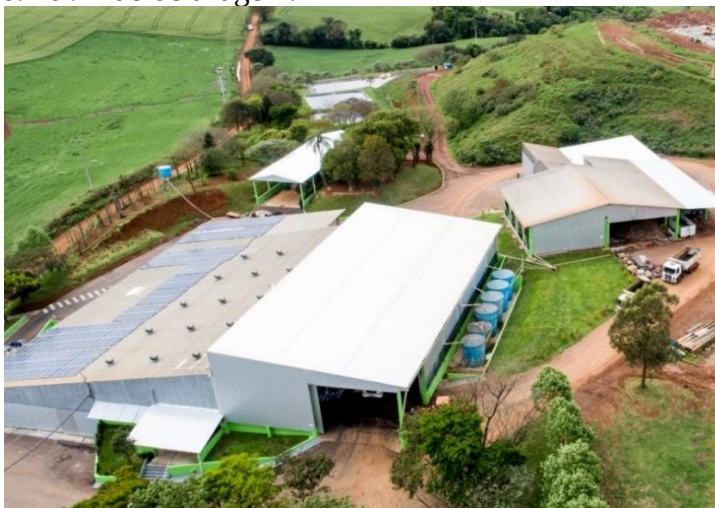
Figura 26: Pavilhão de triagem.
