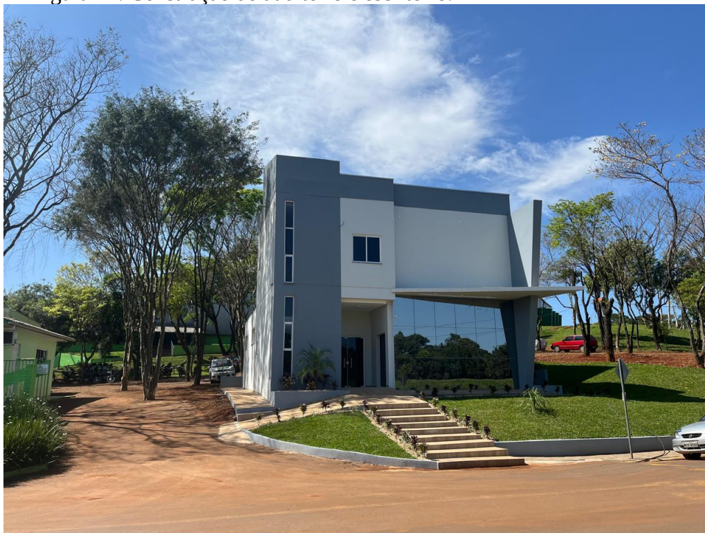
Figura 24: Construção do auditório e escritório.
